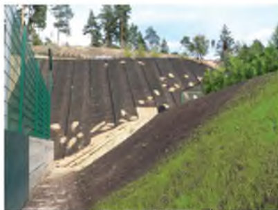
Рисунок 9 – Укріплення насипів дорожніми сітками
