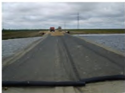
Рисунок 8 – Застосування базальтових сіток при будівництві доріг
