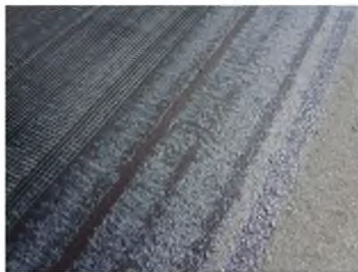
Рисунок 7 – Укладання дорожньої сітки між шарами асфальтобетонного покриття
