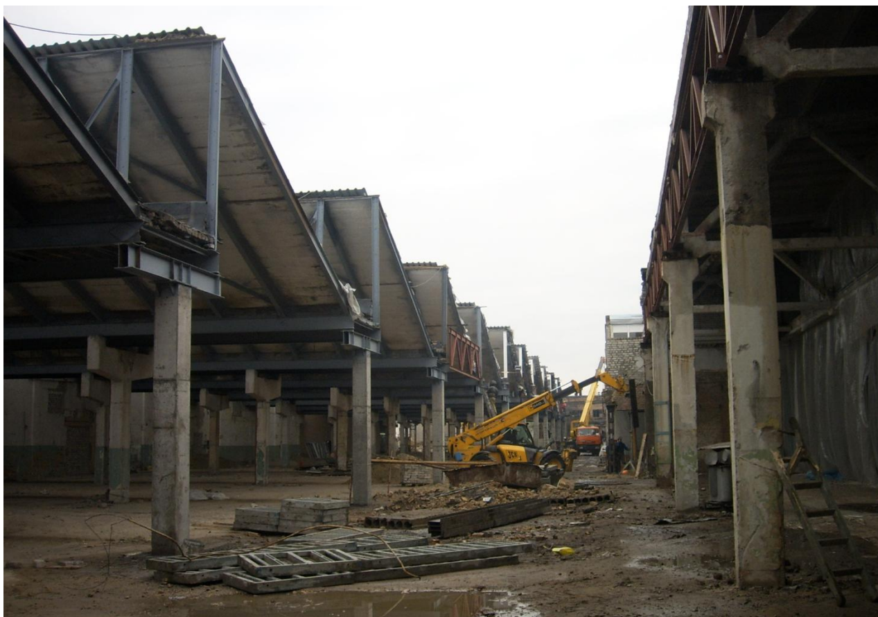
Рисунок 5.1 – Загальний вигляд конструкцій покриття при реконструкції промислової будівлі
