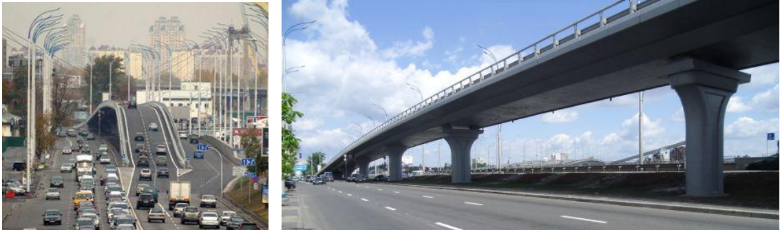
Рис. 4.2. Загальний вигляд естакади
