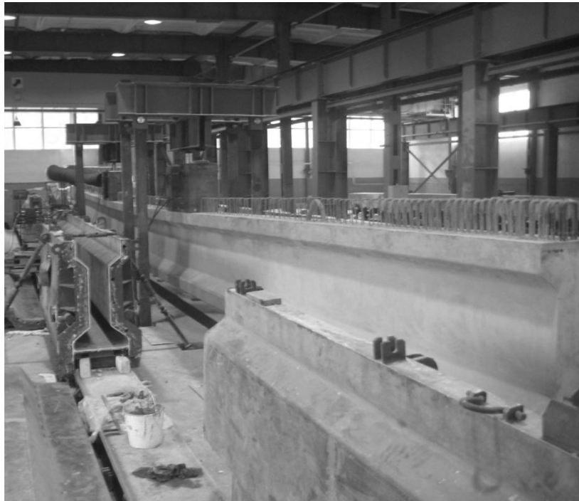
Рис. 2.13. Загальний вигляд випробування балки Б2100.110.40 на універсальному стенді (зліва – опалубка для бетонування балок)
