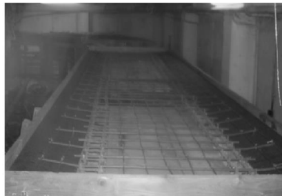
Рис.2.26. Армування плити дослідної конструкції : а) армування нижньою сіткою прямолінійної частини дослідної конструкції; б) армування нижньою і верхньою сітками плити криволінійної частини дослідної конструкції.
