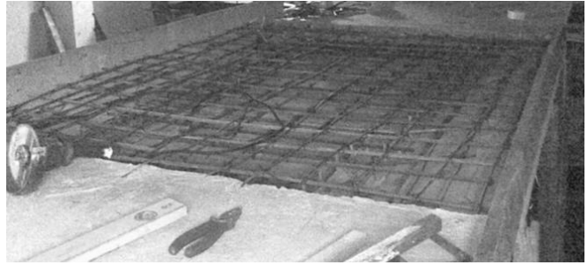
Рис. 2.33. Об'єднання прямолінійної і криволінійної частин дослідної конструкції в прогоні С-Д: а) опалубка для монолітної частини балок і плити б) армування плити сітками
