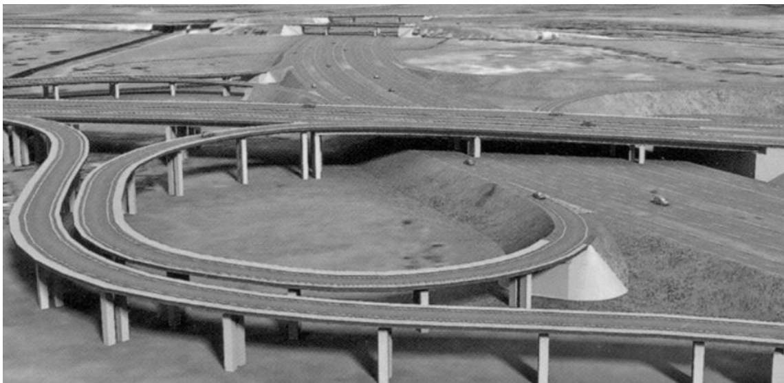
Рис.1.10. Транспортна розв'язка із наявністю примикань і розгалужень транспортних споруд та кривих у плані.
