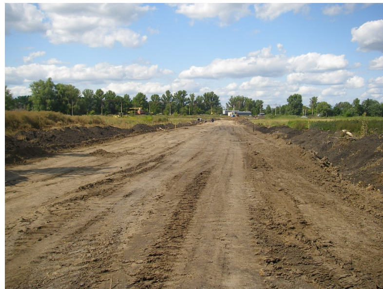
Рис. 4.4 Зведення ґрунтового насипу на об'єкті №4: а – ущільнюючий механізм – каток на базі скрепера МОАЗ 6014; б – вигляд ЗП після укочування
