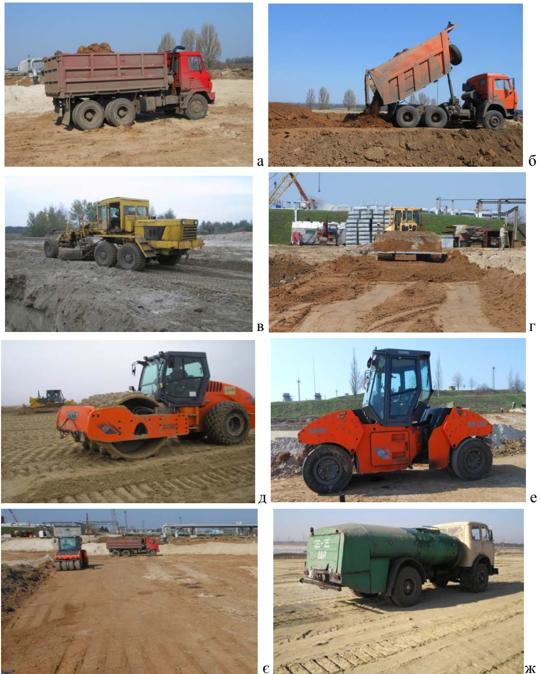
Рис. 4.1 Етапи зведення ґрунтового дорожнього насипу:
