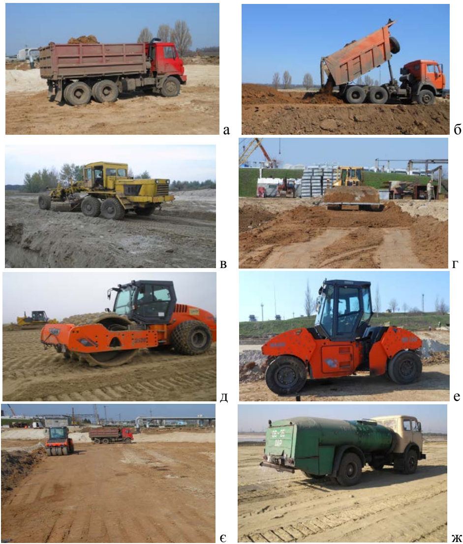
Рис. 5. Етапи зведення ґрунтового дорожнього насипу: а – доставка матеріалу на трасу для зведення ґрунтового насипу; б – відсипання ґрунту в тіло дорожнього насипу; в – планування ЗП до горизонтального рівня грейдером; г – планування ЗП до горизонтального рівня бульдозером; д – ущільнення ґрунту одnobарабанним кулачковим самохідним вібраційним катком НАММ 3520; е, е – ущільнення ґрунту пневмоколісним катком Hamm HD 150 ТТ; ж – дозволення ґрунту поливомийною машиною
