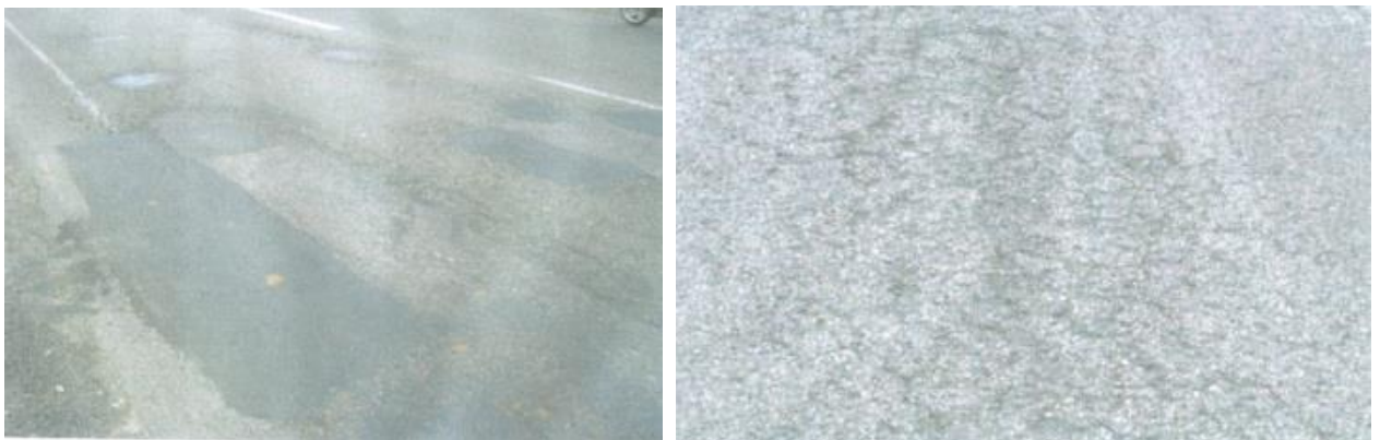
Рис. 4.8 Дефекти на ділянці автомобільної дороги Київ-Ковель (км 297+700 – км 302+400) через 8,5 років після виконання холодного ресайклінгу
