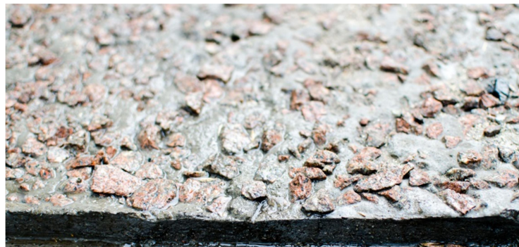
Рис. 4.9. Загальний вигляд цементного покриття
