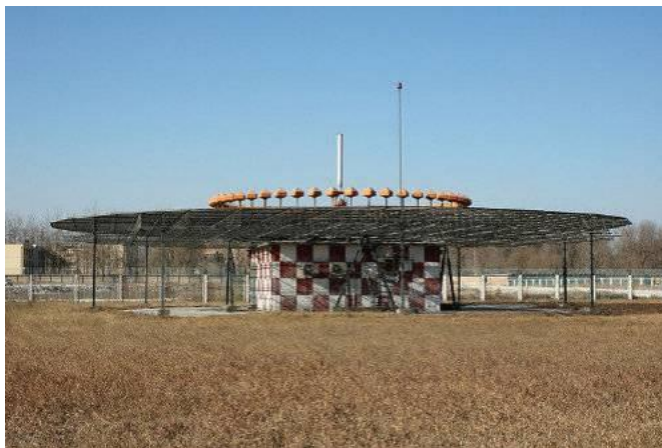
Рис. 3.8. VOR система сумісна з DME системою
