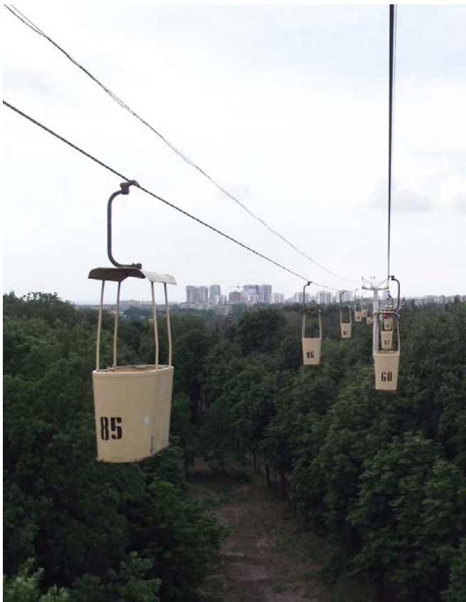
Рисунок 4.43 – Харківська підвісна дорога
