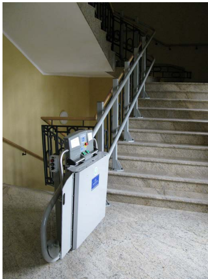
Рисунок 4.3 – Платформа для транспортування інвалідів сходами в музеї (місто Познань, Польща)
