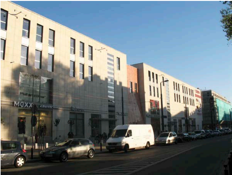
Рисунок 23 – Приклад «гомогенного поля» в сучасній забудові (фрагмент «Галереї Краківської», Польща. Фото авторів)
