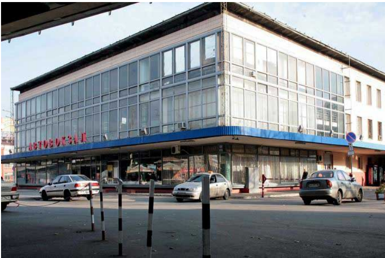
Рисунок 6.23 – Центральный автовокзал «Київ-1». Зовнішній вигляд
