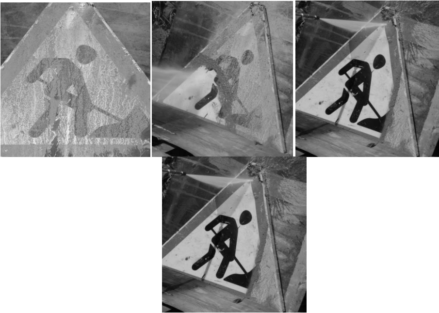
Рис.5.12. Поетапне очищення поверхні дорожнього знака від забруднення за допомогою гідроструменевого методу
