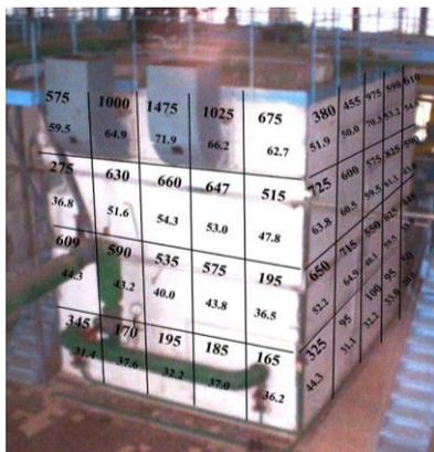
Рис. 3.5. Распределение плотности теплового потока и температуры на боковых стенках водогрейного котла ТВГ-8
