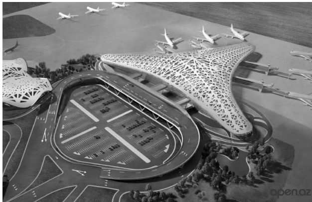
рис.1 Вид аерокомплексу в м. Баки з пташиного польоту
