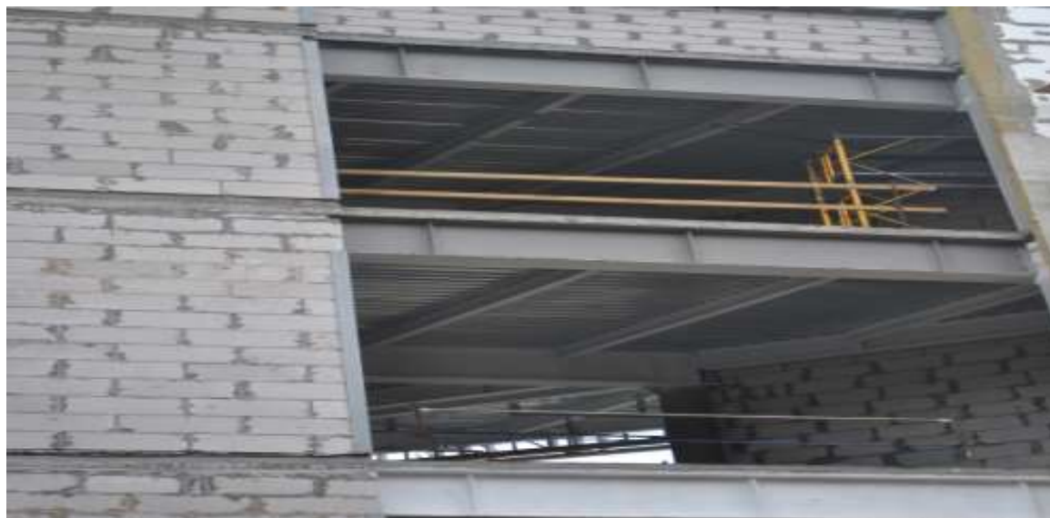
Рис. Г. 3. Застосування сталезалізобетонних перекриттів із зовнішнім армуванням профільованого настилу з виштамповками
