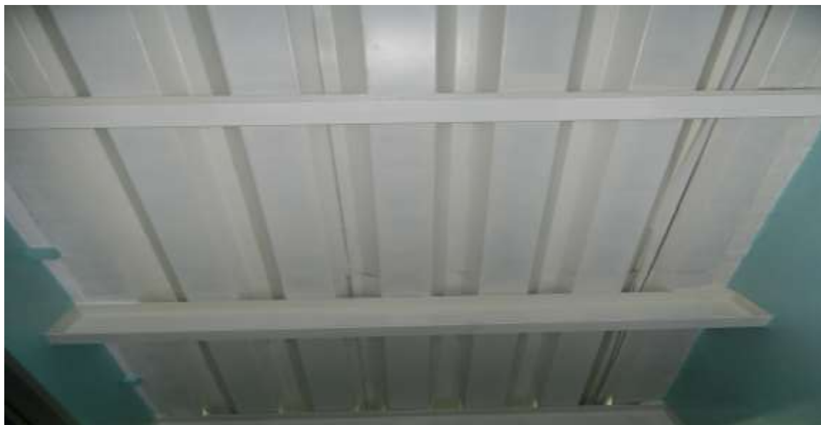
Рис. Г. 5. Впровадження сталезалізобетонних перекриттів із зовнішнім армування профільованого настилу з виштамповками
