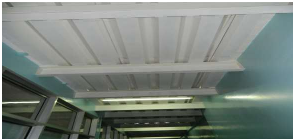
Рис. Г. 4. Впровадження сталезалізобетонних перекриттів із зовнішнім армування профільованого настилу з виштамповками
