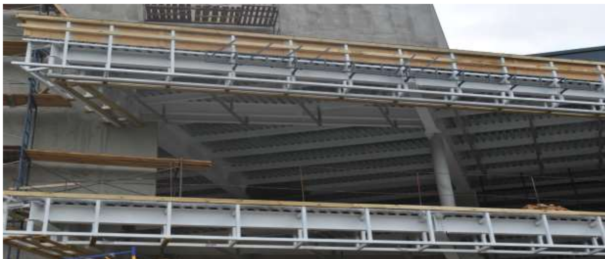
Рис. Г. 2. Застосування сталезалізобетонних перекриттів із зовнішнім армуванням профільованого настилу з виштамповками
