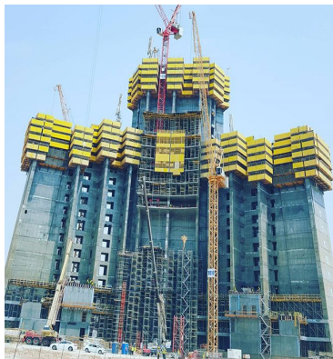
Рис. 1.24. Технологія зведення хмарочоса «Королівська вежа»
