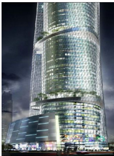
Рис.1.79. Зовнішнє покриття по зміщеному трикутним формам
