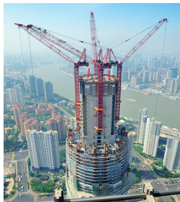
Рис. 1.25. Притяжні крани для будівництва хмарочосів
