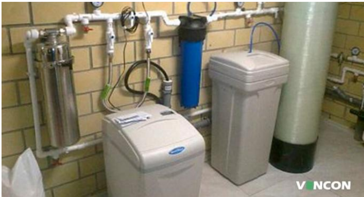
Рис 6. Кабінетні фільтри
