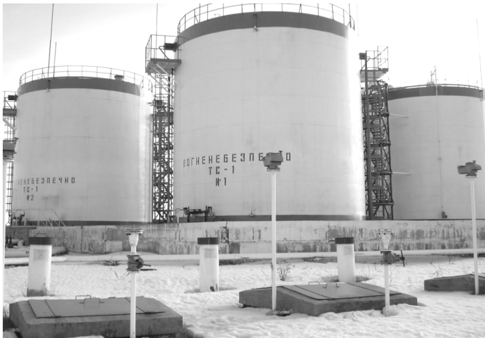
Рис. 2.3. Зовнішній вигляд резервуарів на складі зберігання палив
