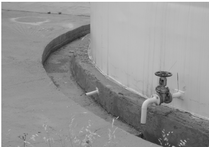
Рис. 2.14. Зовнішній вигляд резервуара з детектуванням можливих витікань палив з дна
