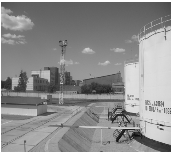
Рис. 2.16. Організація суцільного бетонного обвалування зони зберігання палив
