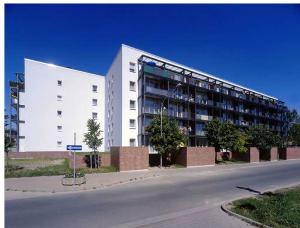
б) після реконструкції
