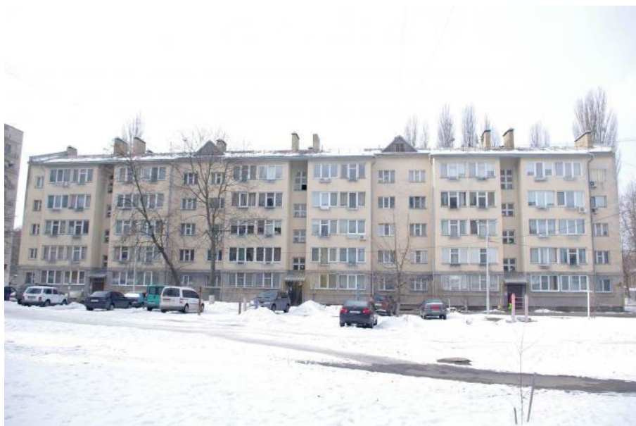
Рис.1.9.Відреконструйований будинок по вул.Туполева, 16 Ж
