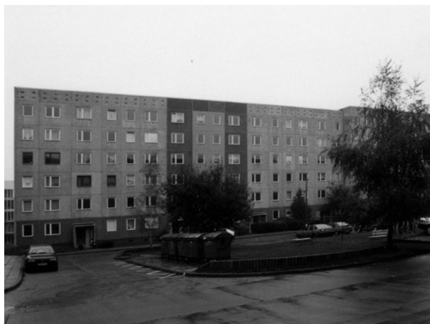
а) до реконструкції
