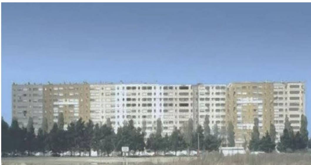
а) до реконструкції
