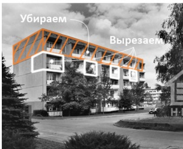
а) до реконструкції
