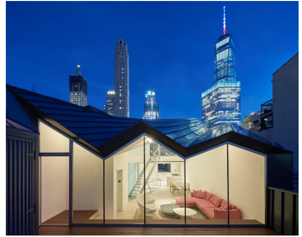
г) пентхаус на даху будівлі
