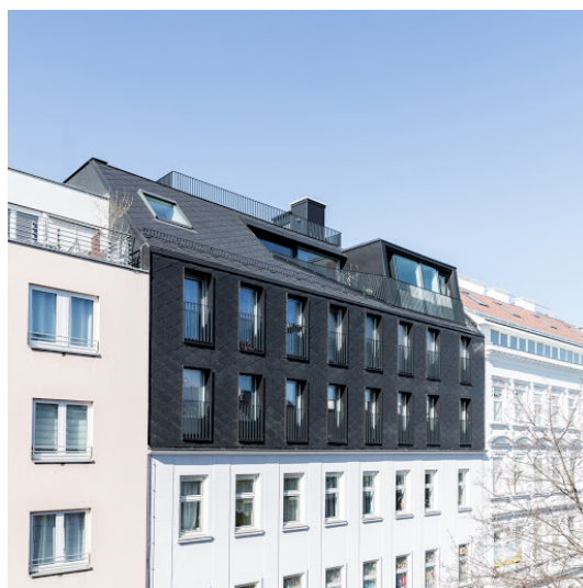
б) після реконструкції
