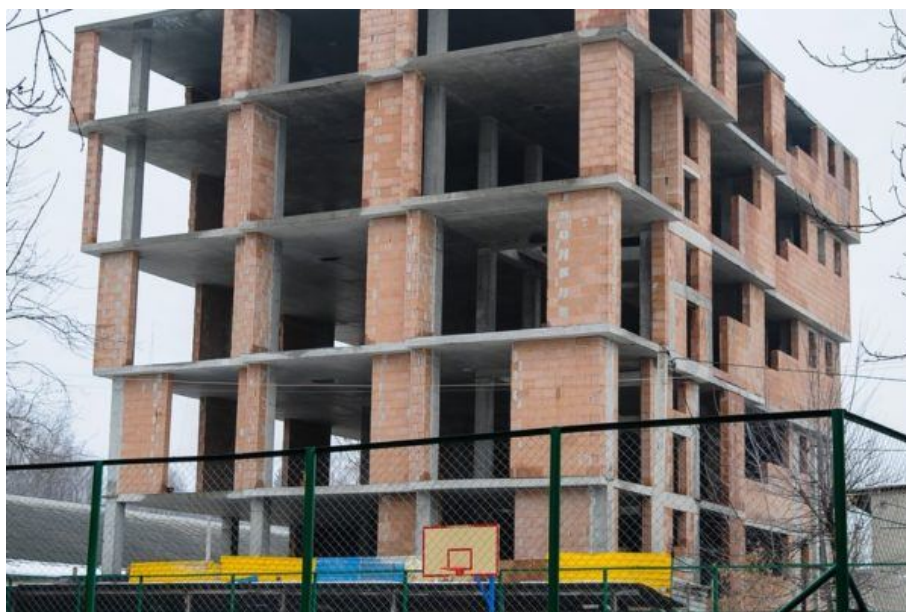
Рис. 5.4. Монолітно –каркасна технологія будівництва
