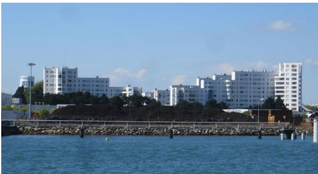
б) після реконструкції
