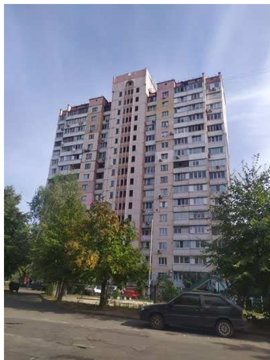
б) будинок по пр. Леся Курбаса 1, корпус 2
