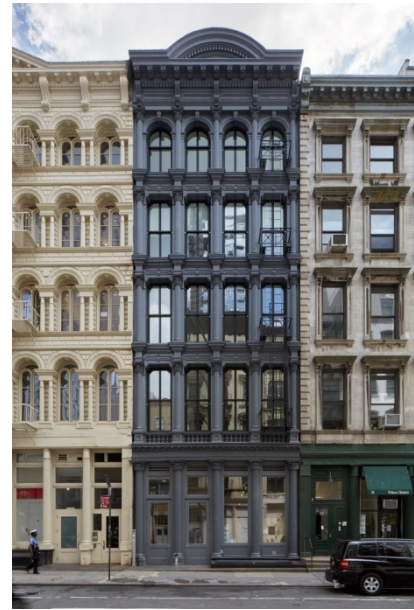
б) після реконструкції
