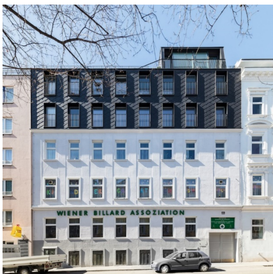
а) після реконструкції
