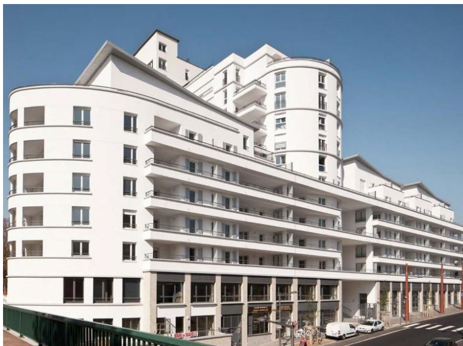
б) після реконструкції
