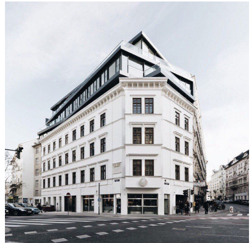
б) після реконструкції
