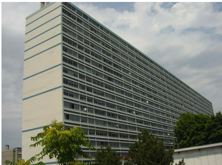
а) до реконструкції
