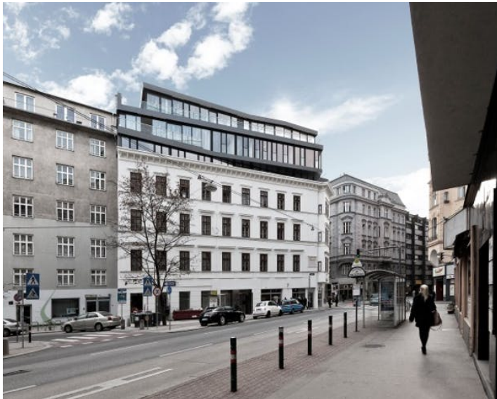
а) після реконструкції
