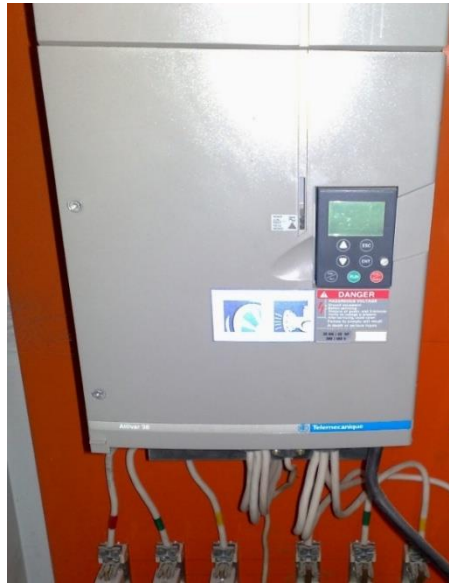
Рис. 2.7. Частотний перетворювач Altivar 38
