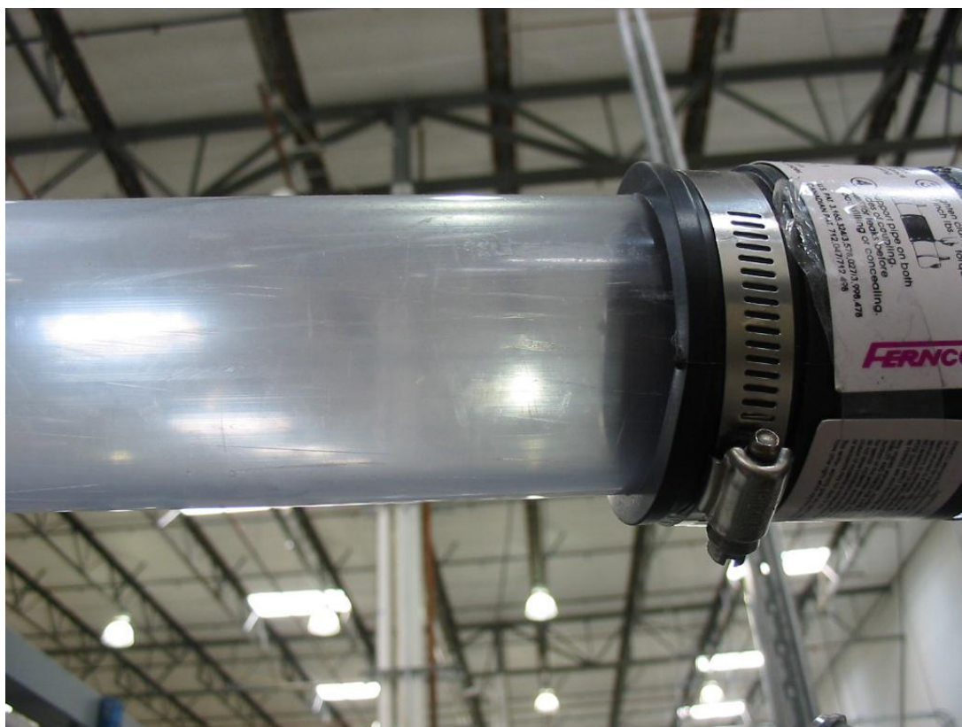
Рис. 5.5. Трубопровід вакуумізації при 100% заповненому баку.
