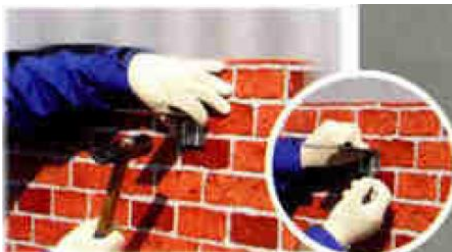
Рисунок 4.1 – Встановлення кронштейнів
