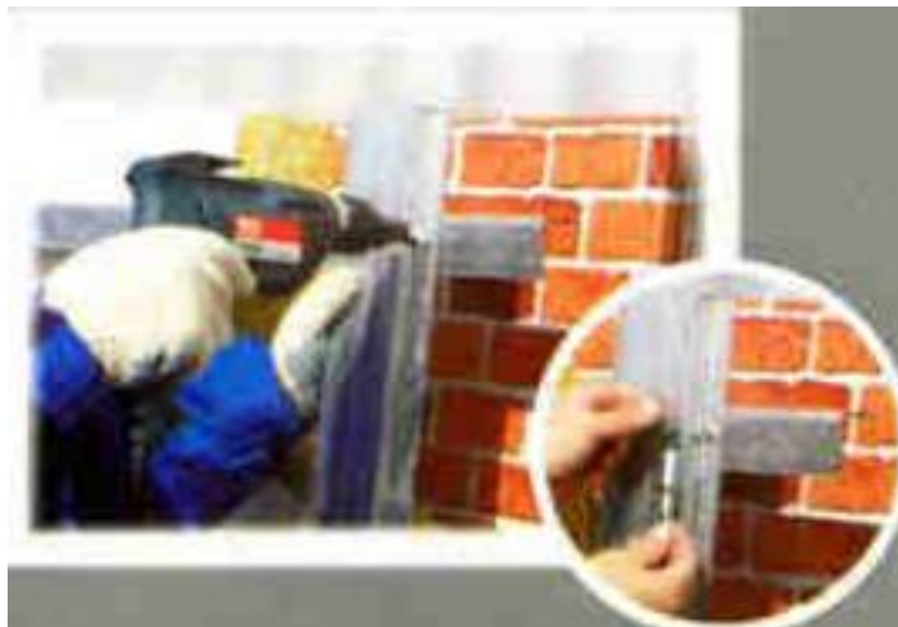
Рис.4. – Встановлення вертикальних профілів
