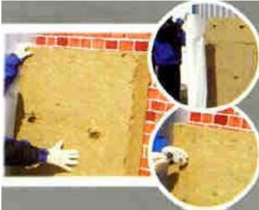
Рисунок 4.2 – Влаштування утеплювача
