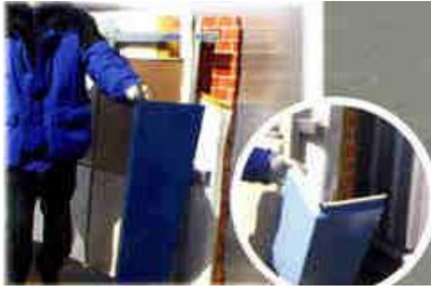
Рис.6. – Місця примикань фасадних касет до віконних прорізів
