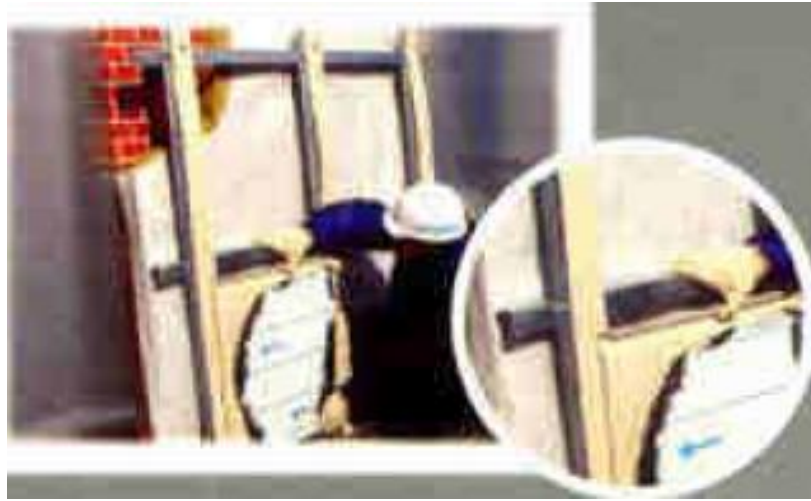
Рис.5. – Монтаж фасадної касети в напрямку зліва вгору
