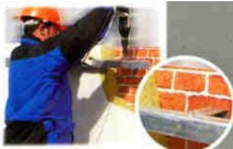
Рис.3. – Встановлення горизонтальних напрямних профілів
