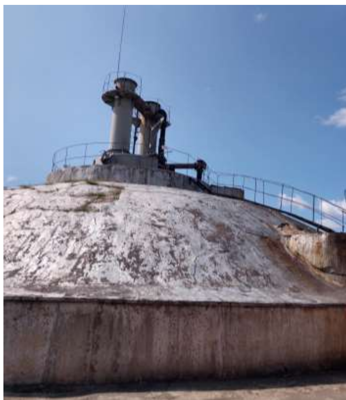
Рис. 3.1. Метантенк на Бортницькій станції аерації
