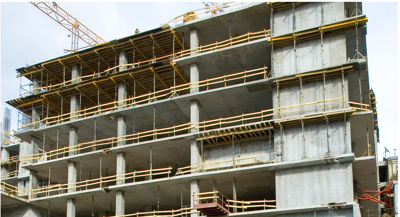
Рис. 2.1 Каркасно-монолітна конструктивна система
