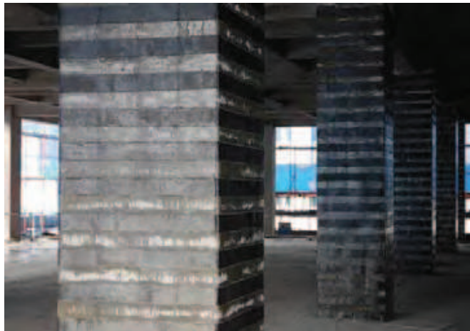
Рис 2. Схема підсилення колон вуглеволокном
