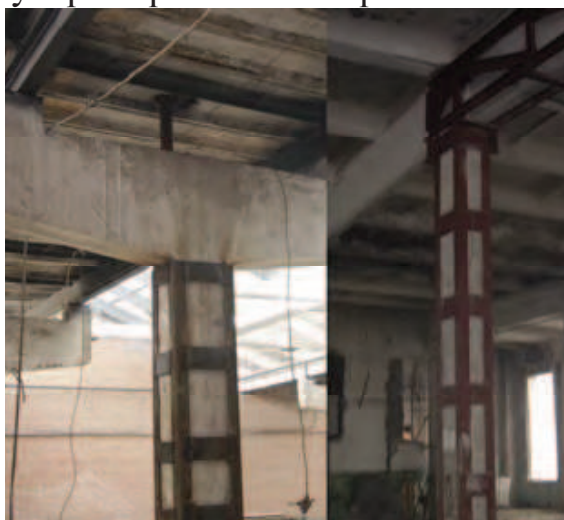
Рис 1. Схема підсилення колон сталевими кутиками
