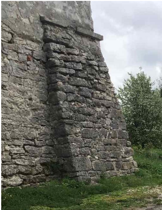
б) фотофіксація опорної стінки з бутового каменю Південно-Західного корпусу замку Свірж
