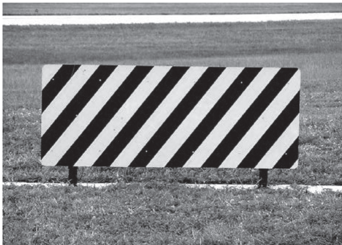
Ilustracja 73. Oznaczenie końca drogi kołowania
