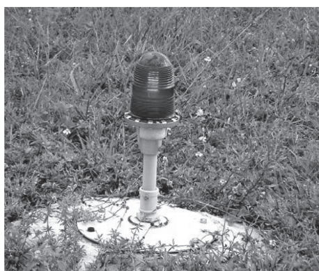
Ilustracja 62. Światło krawędzi drogi kołowania
