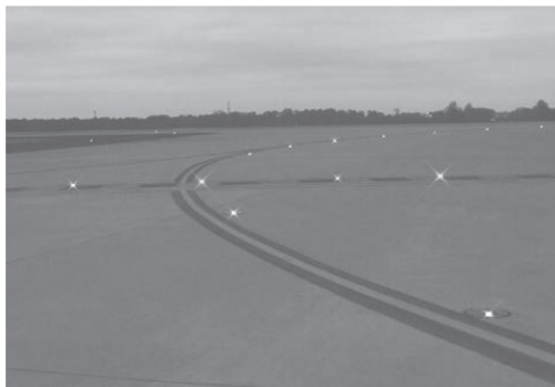
Ilustracja 65. Światła ochronne w nawierzchni
