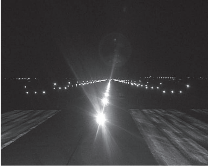
Ilustracja 63. Światła linii środkowej drogi startowej
