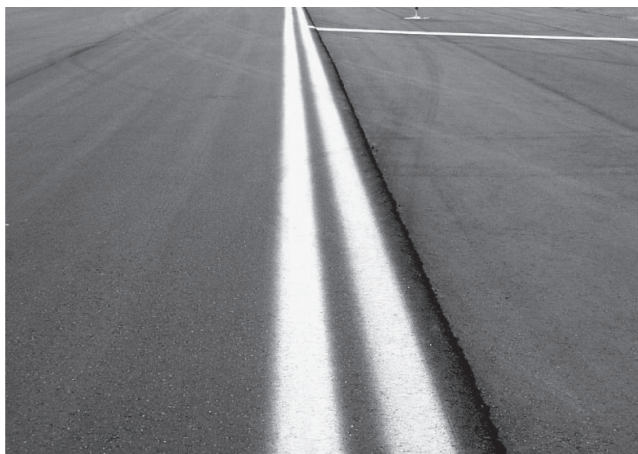
Ilustracja 56. Linia ciągła krawędzi drogi kołowania
