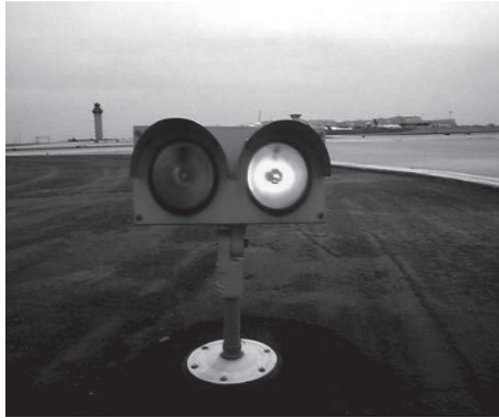
Ilustracja 64. Pionowe światła ochronne drogi startowej
