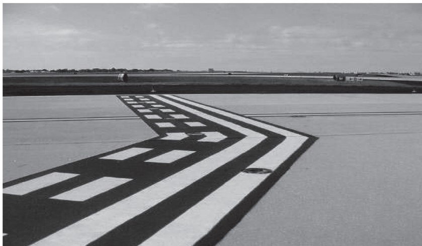
Ilustracja 49. Linia miejsca oczekiwania przed drogą startową
