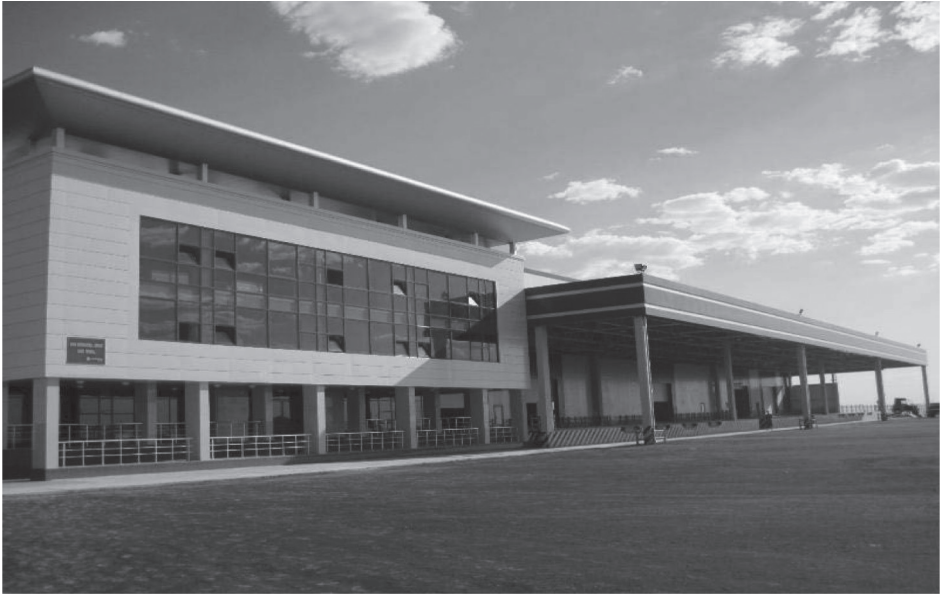
Ilustracja 25. Budynek operacyjny, port lotniczy Navoi
