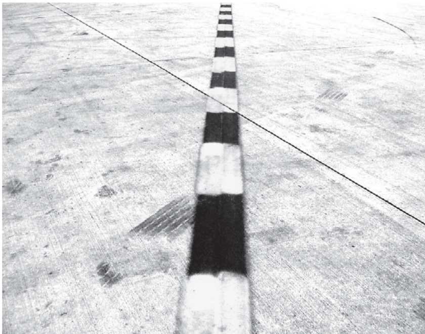
Ilustracja 52. Linia pośredniego miejsca oczekiwania (droga kołowania/droga kołowania)
