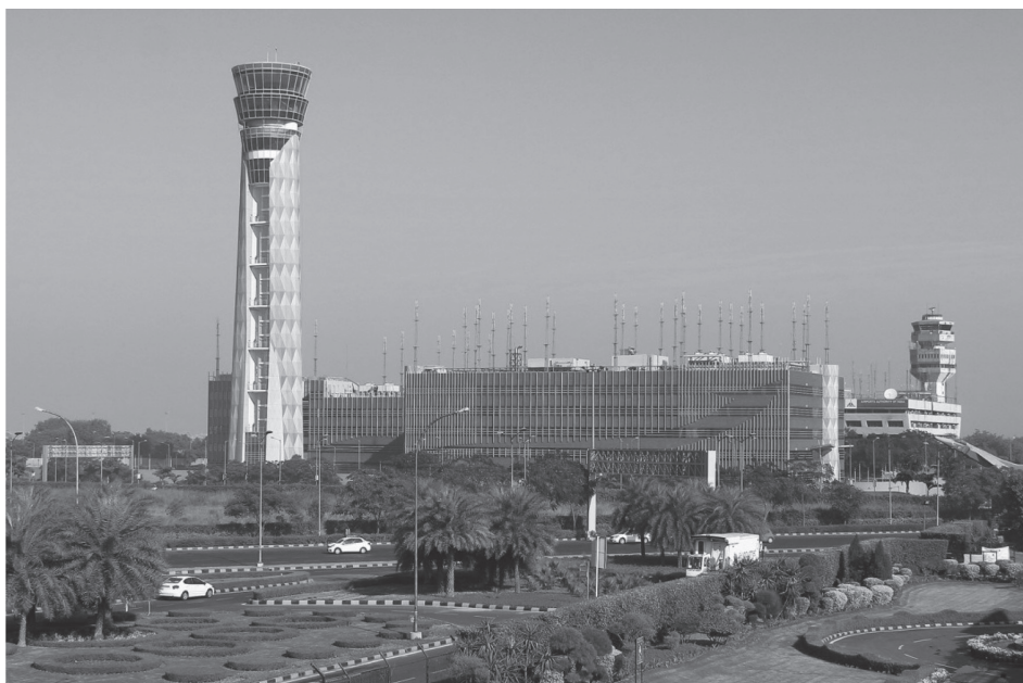
Ilustracja 77. Wieża kontroli lotów
