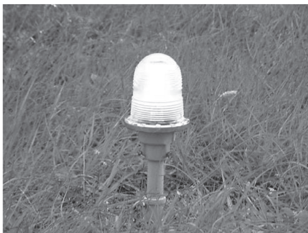
Ilustracja 60. Białe światło krawędzi drogi startowej
