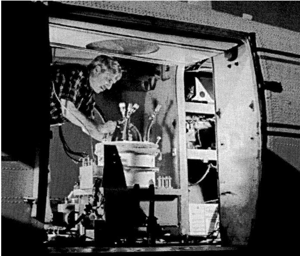
Рисунок 1.18 - Система SEBASS в салоні літака Twin Otter [19]
