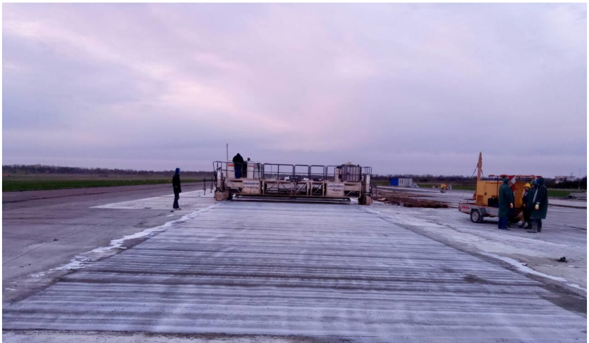
Рис. 5.2 Укладання цементобетонної суміші на ремонтних ділянках
