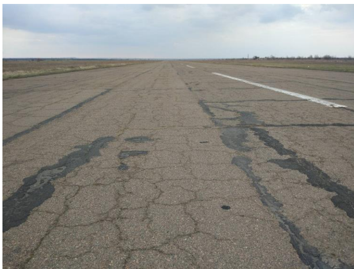
Рис. 2.5. Дефекти у вигляді сітки тріщин по типу «крокодилова шкіра»
