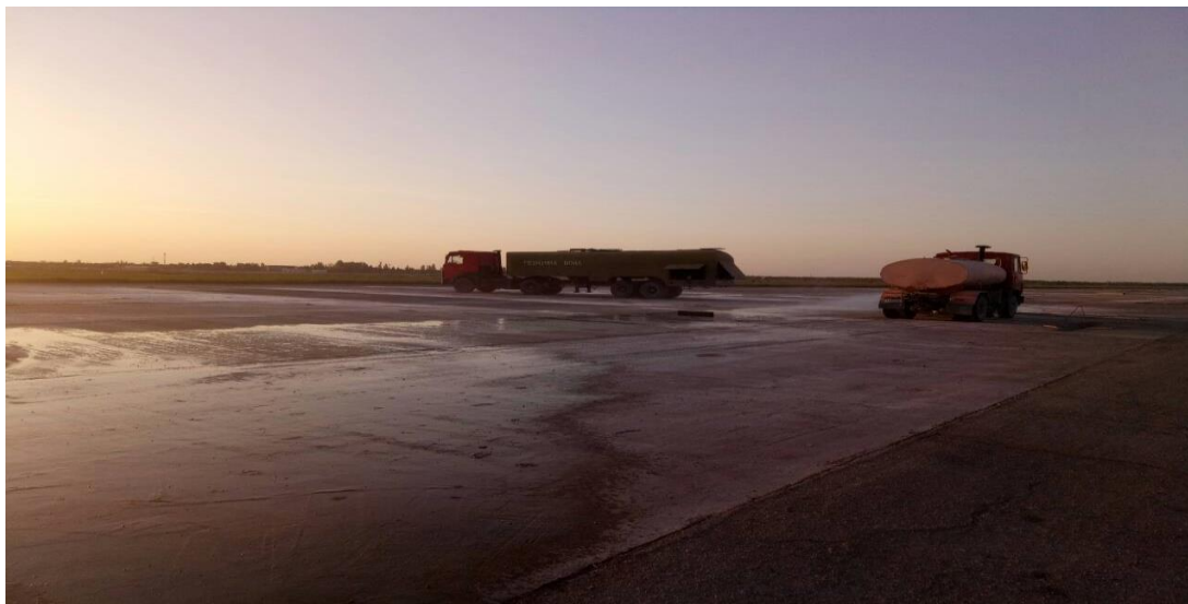
Рис. 5.3 Догляд і очищення цементобетонного покриття
