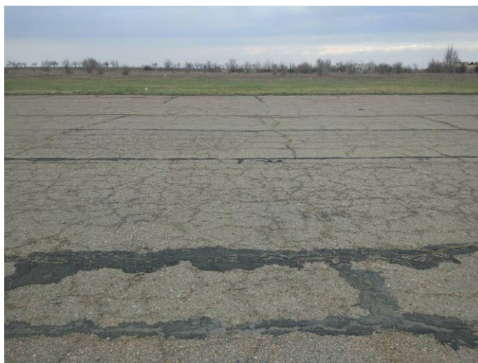
Рис. 2.5. Дефекти у вигляді сітки тріщин по типу «крокодилова шкіра»
