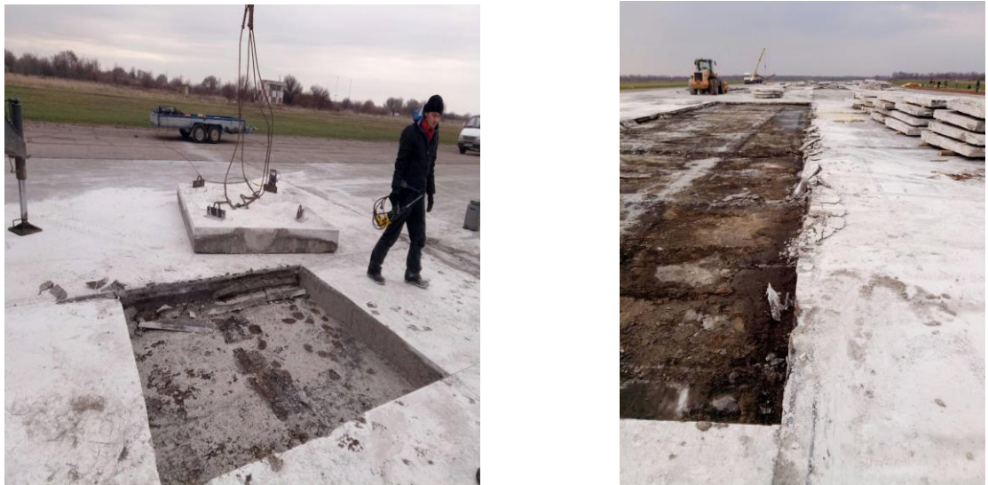
Рис. 5.1 Демонтаж випиляних плит
