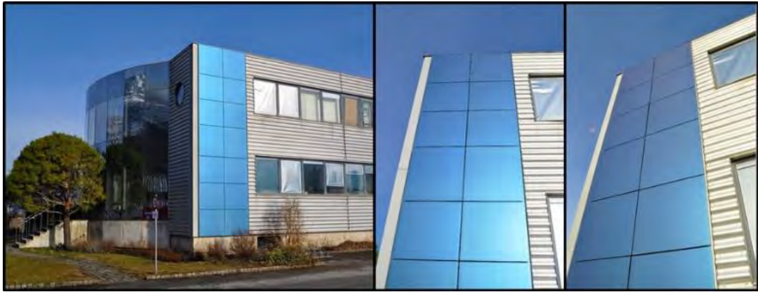
Рис. 4.11. Зовнішній вигляд енергоефективної будівлі з фотоелектричних панелей
