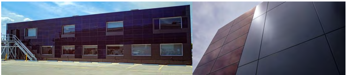
Рис. 5.14. Зовнішній вигляд енергоефективної будівлі з фотоелектричних панелей
