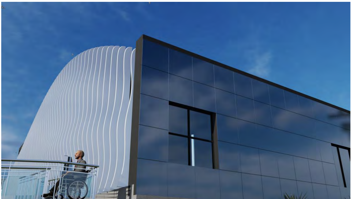
Рис. 4.12. Фотоелектричні панелі на південному фасаді 1-го корпусу
