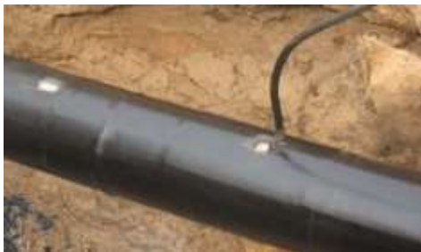
Рис.4.6.Спосіб під'єднання протектора до трубопроводу зварюванням
