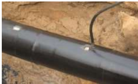
Рис.1.6. Спосіб під'єднання протектора до трубопроводу зварюванням
