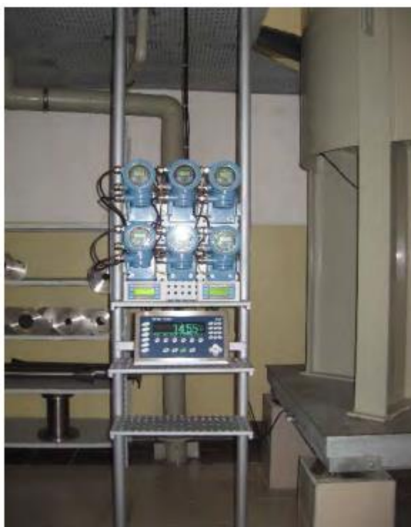
Рис. 2.8. Виносні термінали масових витратомірів
