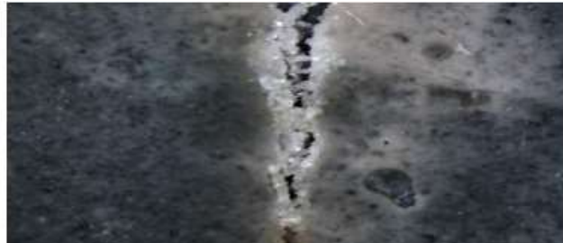
Рис. 3.3. Процес герметизації тріщини
