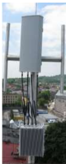
Рис. 1.7. Приклад кріплення Базової станції WiMAX/LTE: Airspan Air4G (MacroMAXe)
