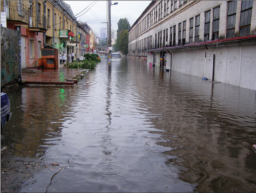
Рис. 7.4. Затоплена вул. Пестеля після зливи 25.07.2018 р.
