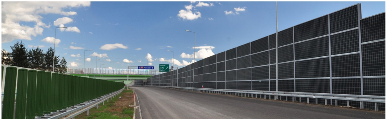
Рис 1.4.1 Приклад акустичного екрану [7]
