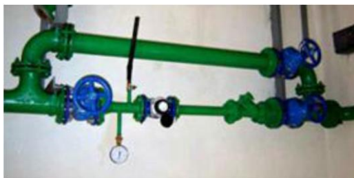
Рисунок 5.51 – Водомірний вузол
