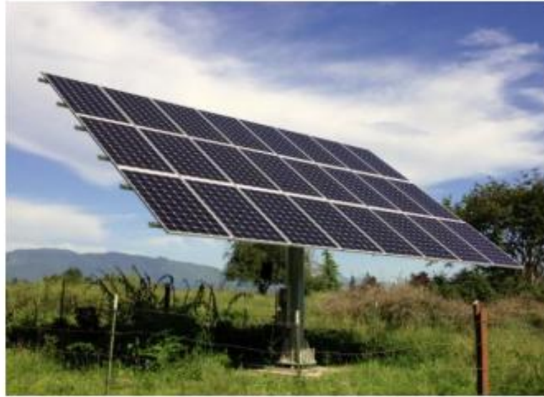
Рис.2.7. Трекер з двома осями обертання (TTDAT)
