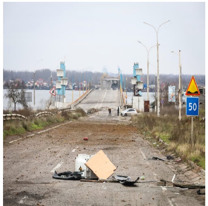
Рисунок 1.1 Руйнування покриття внаслідок бойових дій
